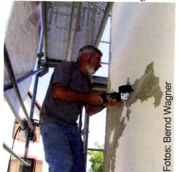
Am 11.08.2012 wird mit den Arbeiten an der Fassade begonnen.
